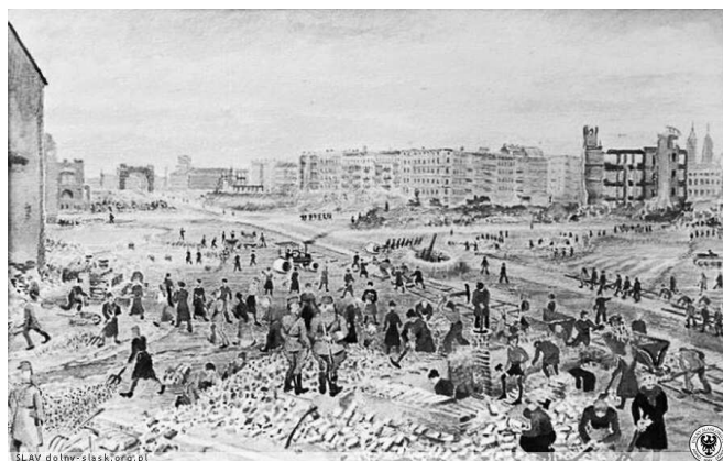
Rys. 6. Budowa lotniska w Festung Breslau (przełom 1944/45 r.) na terenie obecnego pl. Grunwaldzkiego, w głębi zarys Mostu Grunwaldzkiego; foto ze zbiorów Muzeum m. Wrocławia
