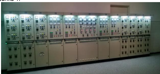
Rys. 1. Główna elektryczna tablica rozdzielcza (GTR)
