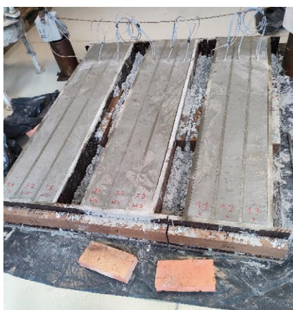
Rys. 2. Belki w formach po zalaniu betonem
