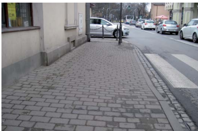
Fot. 1. Zwiększone pochylenie poprzeczne wymuszone obniżeniem na przejściu dla pieszych – Wieliczka (fot. K. Kasperczyk)
