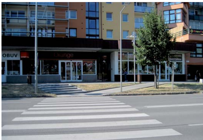
Fot. 4. Dostęp do przejścia schodami oraz pochylnią zapewnia łatwy dostęp do przejścia osobom na wózkach inwalidzkich – Bardejów/Słowacja (fot. K. Kasperczak)
