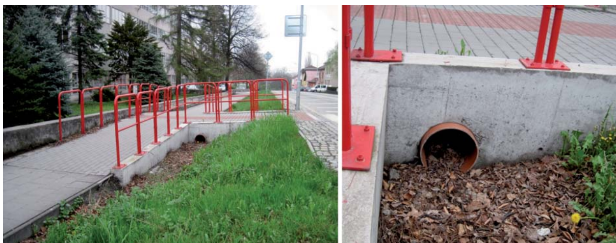
Fot. 8a i 8b. Podniesiona całość chodnika zapewnia korzystną segregację pieszych, dogodny dostęp do przejścia, nieprzeszkadzające odwodnienie i możliwość ułożenia pasa informacyjnego dla osób niewidomych i słabowidzących – Czeski Cieszyn/Czechy (fot. autor)
