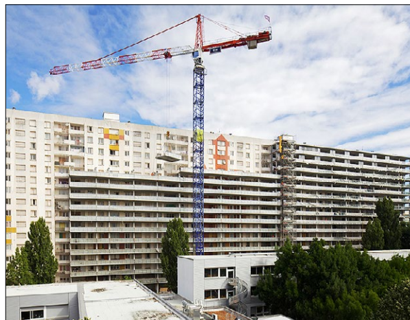
Ryc. 6. Grand Parc Bordeaux, widok w trakcie prac modernizacyjnych; źródło: archdaily.com
