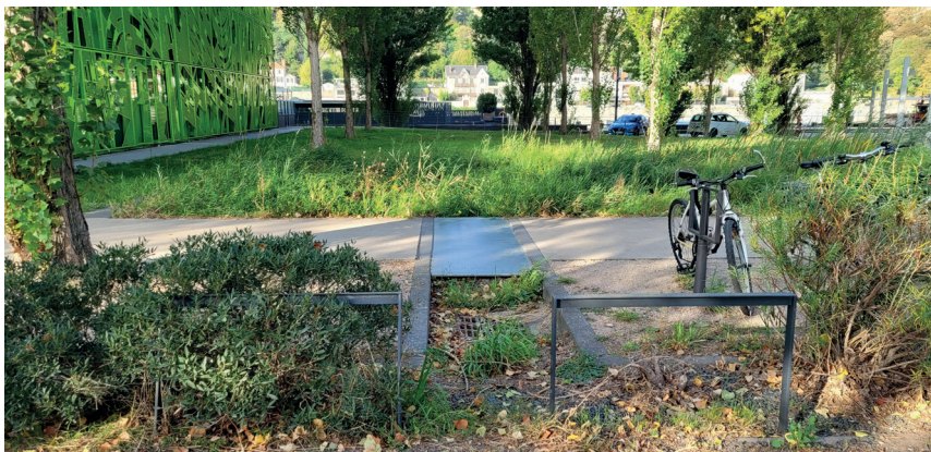
Rys. 3. Niekka retencyjna zbierająca wodę z ciągu pieszo-jezdnego przy Rue Hrant Rink; źródło: fot. Szymon Opania
