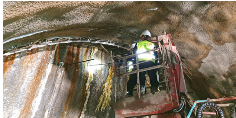
Ryc. 7. Iniekcja stropu klejem poliuretanowym ERKADUR® / ERKADOL® K w nitce TD-2.2 S
