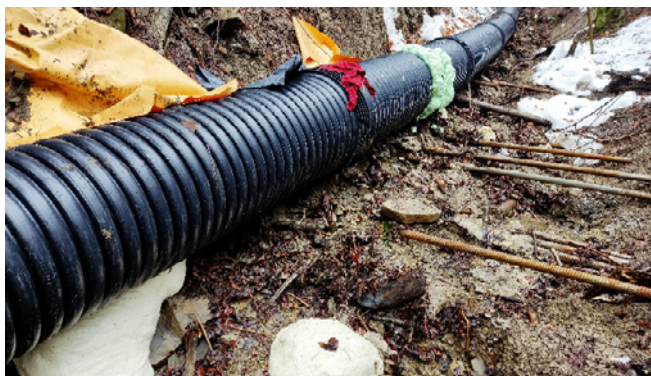
Ryc. 6. Klejenie przodka TD-2.2, po prawej stronie widoczny wypływ kleju na powierzchnię
