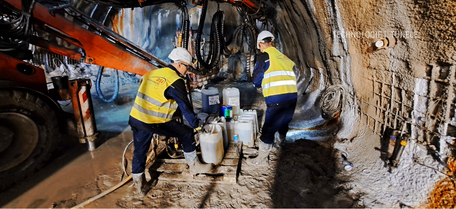
Ryc. 2. Iniekcja stropu klejem poliuretanowym ERKADUR® / ERKADOL® K w nitce tunelu TD-2.1 S
