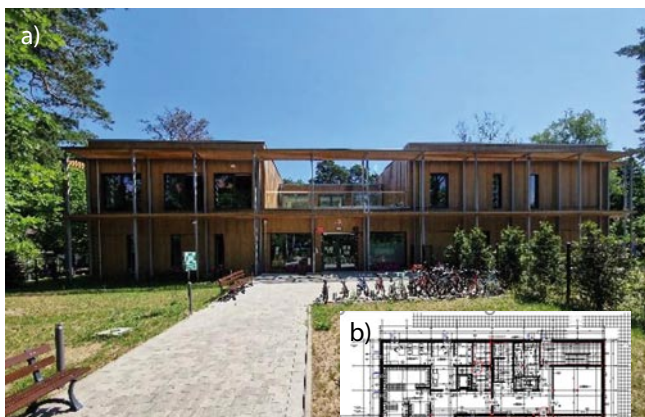
Rys. 1. Budynek przedszkola: a) widok ogólny b) rzut parteneru z zaznaczonym pomieszczeniem w którym wykonywano pomiary
