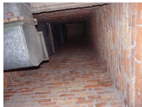
Rys. 2. Wnętrze murowanego szachtu instalacyjnego
