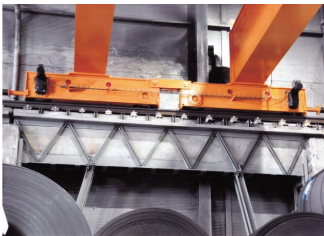
Rys. 6. Fragment wykonanej konstrukcji wzmocnienia: a) belek podsuwnicowych, b) słupów
