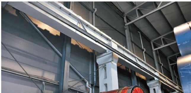
Rys. 2. Widok belek podsuwnicowych i słupów przed wzmocnieniem
