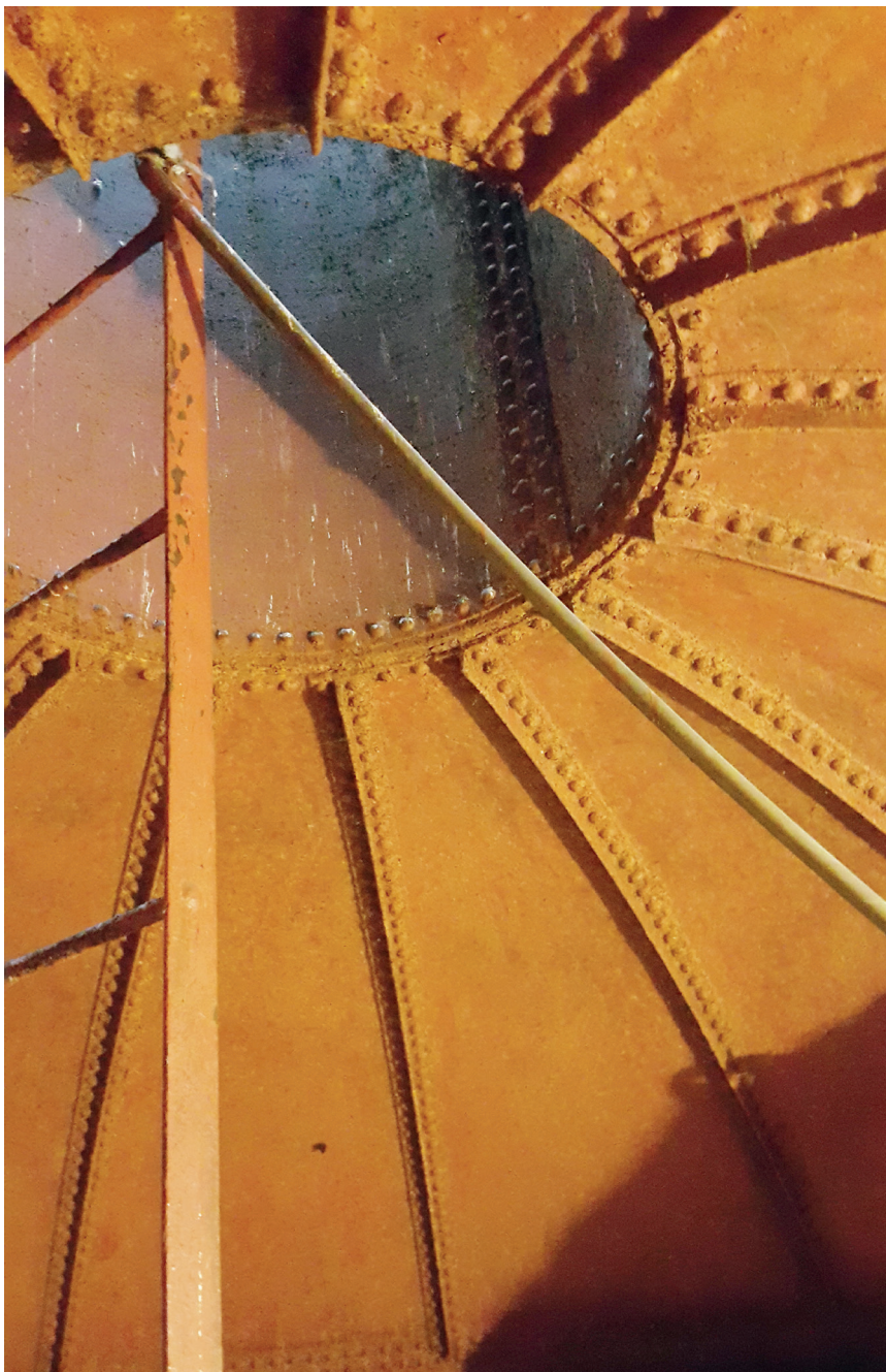
Wodociągowa wieża ciśnień w Wąbrzeźnie – spód zbiornika
