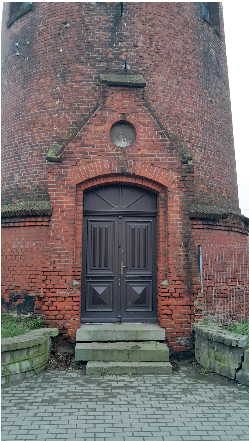
Wodociągowa wieża ciśnień w Wąbrzeźnie – portal wejściowy
