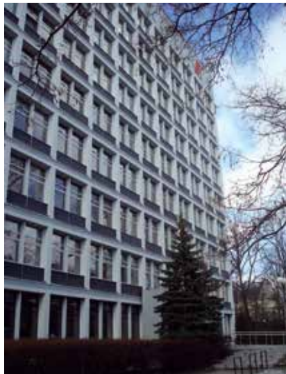
Fot. 2. Elewacja frontowa budynku architektury; źródło: archiwum autorów, 2023
