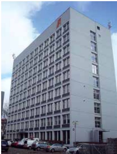
Fot 1. Elewacja tylna budynku architektury; źródło: archiwum autorów, 2023
