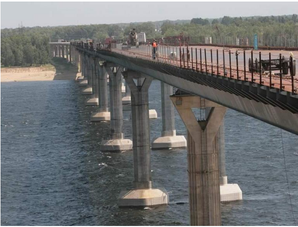
Rys. 9. Widok mostu w Wolgogradzie [2]
