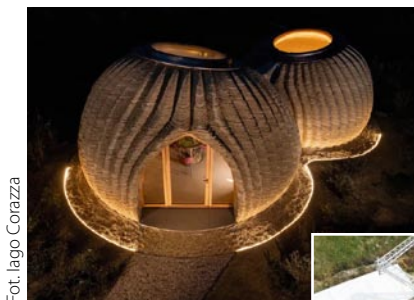
Rys. 2. Realizacja wydruku 3D budynku [2]
