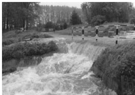
RYSUNEK 2. Przelanie się wody przez koronę budowli piętrzącej (Świniuch 2010) FIGURE 2. Overflow of water through the crest of dam (Świniuch 2010)
