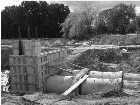
RYSUNEK 7. Budowla upustowa w trakcie realizacji
