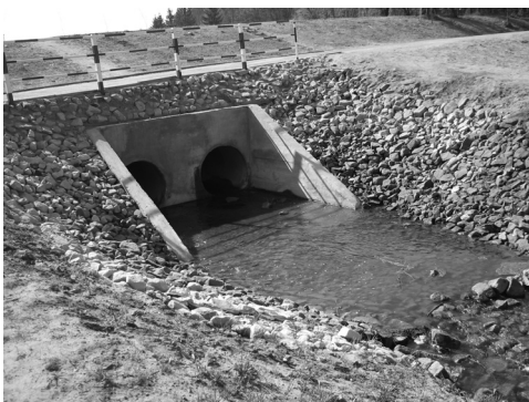
RYSUNEK 8. Zmodernizowana budowla upustowa: a – wieża wlotowa, b – stanowisko dolne
