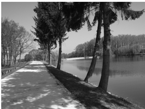
RYSUNEK 9. Lewostronna grobla zbiornika FIGURE 9. Left-dam of reservoir
