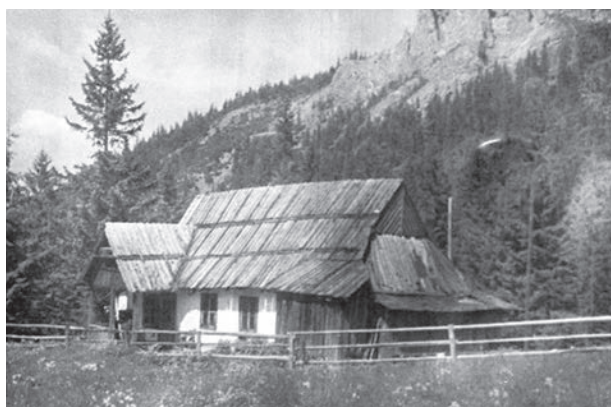
Il. 9. Domek hamernicki, rozebrany przez Niemców w roku 1943, zatracił wskutek przeróbek pierwotny charakter, przyjmując szczególnie w kształcie dachu cechy architektury regionalnej
