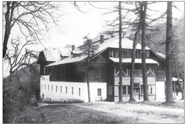
Il. 13. Budynek administracyjny przed przebudową
