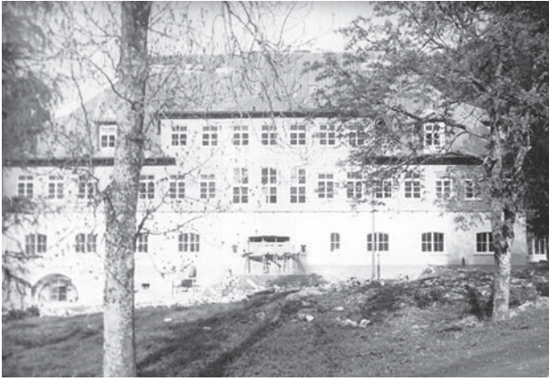
Il. 27. Budynek szkoły domowej pracy kobiet, dawniej administracyjny w końcowym stadium przebudowy, dokonanej w czasie okupacji
