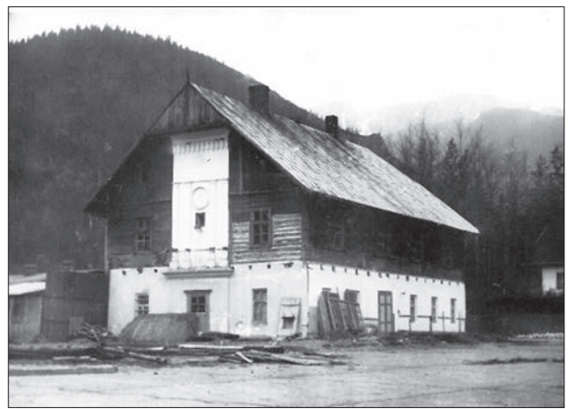
Il. 15. Budynek dawnej modelarni, w którym po przebudowie i nadbudowie zainstalowano gospodę i mieszkania pracownicze. Widoczna ściana wieży z obramieniem tarczy zegara
