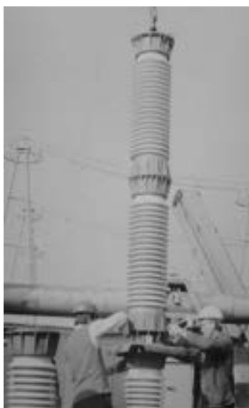
Rys. 9. Montaż aparatury pierwotnej na rozdzielni 750 kV rok 1984 (archiwum prywatne Adam Balawender)
