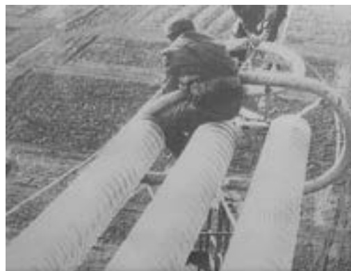
Rys. 7. Prace przy montażu izolatorów szklanych
