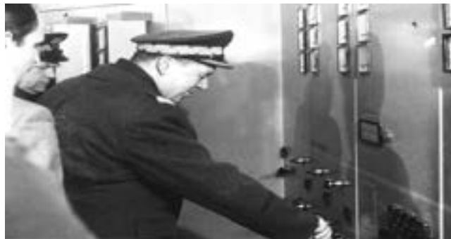
Rys. 11. 20 grudnia 1984 roku godz. 12.20 włączenie układu 750 kV do ruchu. Aktu dokonuje Minister Górnictwa i Energetyki gen. dyw. Czesław Piotrowski
