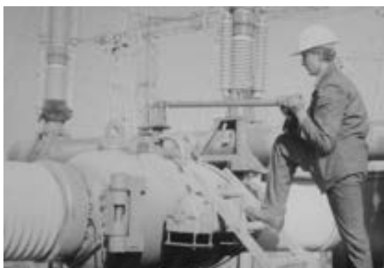
Rys. 10. Prace montażowe na rozdzielni 750 kV rok 1984 (archiwum prywatne Adam Balawender)
