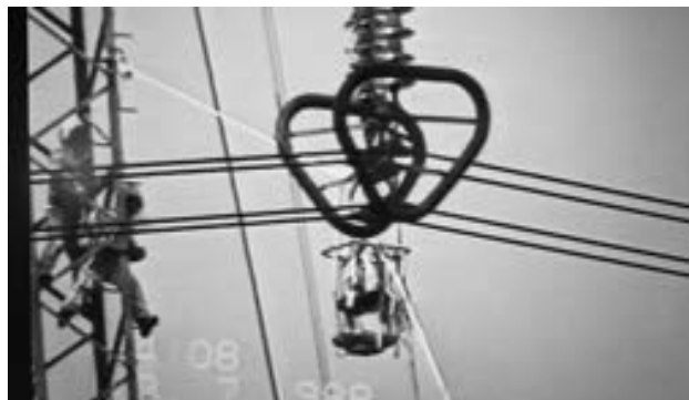
Rys. 15. 13 lipca 1988 roku godz. 14.08 elektryk dojeżdża do linii pod napięciem 750 kV
