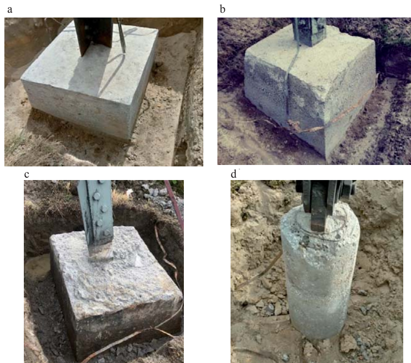
RYSUNEK 3. Oczyszczony fundament: a – stanowisko 134; b – stanowisko 123; c – stanowisko 38; d – stanowisko 108 (fot. A. Brzezińska) FIGURE 3. Cleaned foundation: a – workplace 134; b – workplace 123; c – workplace 38; d – workplace 108 (photo by A. Brzezińska)
