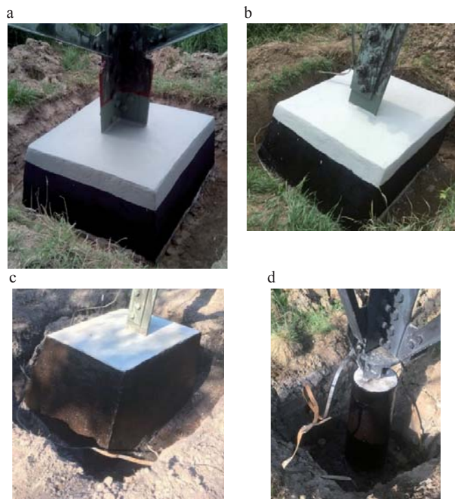
RYSUNEK 5. Fundamenty z naniesioną warstwą ochronną: a – stanowisko 134; b – stanowisko 123; c – stanowisko 38; d – stanowisko 108 (fot. A. Brzezińska)
