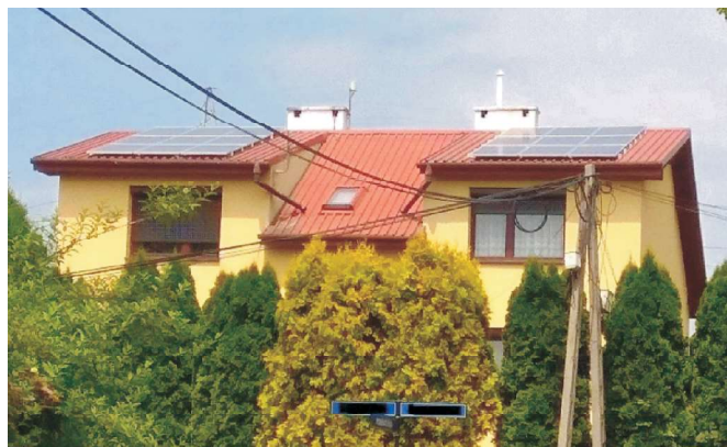
Rys. 1. Mikroinstalacja fotowoltaiczna (PV) o mocy 5,04 kWp Fig. 1. Photovoltaic (PV) micro installation of 5.04 kWp
