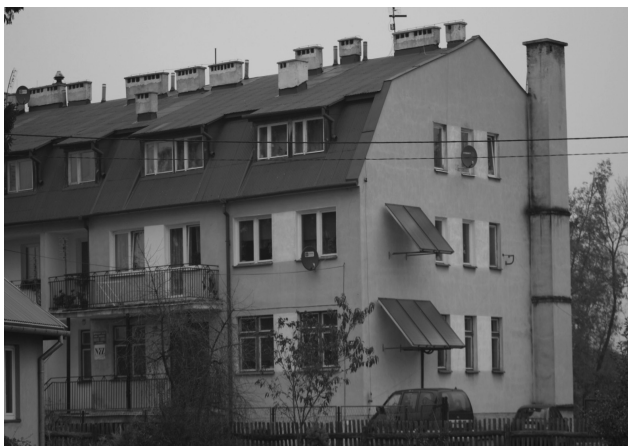
Fotografia 2. Kolektory słoneczne w „obszarze turystycznym Dolina Zielawy”, NZOZ Ośrodek Zdrowia w Podedwórze
