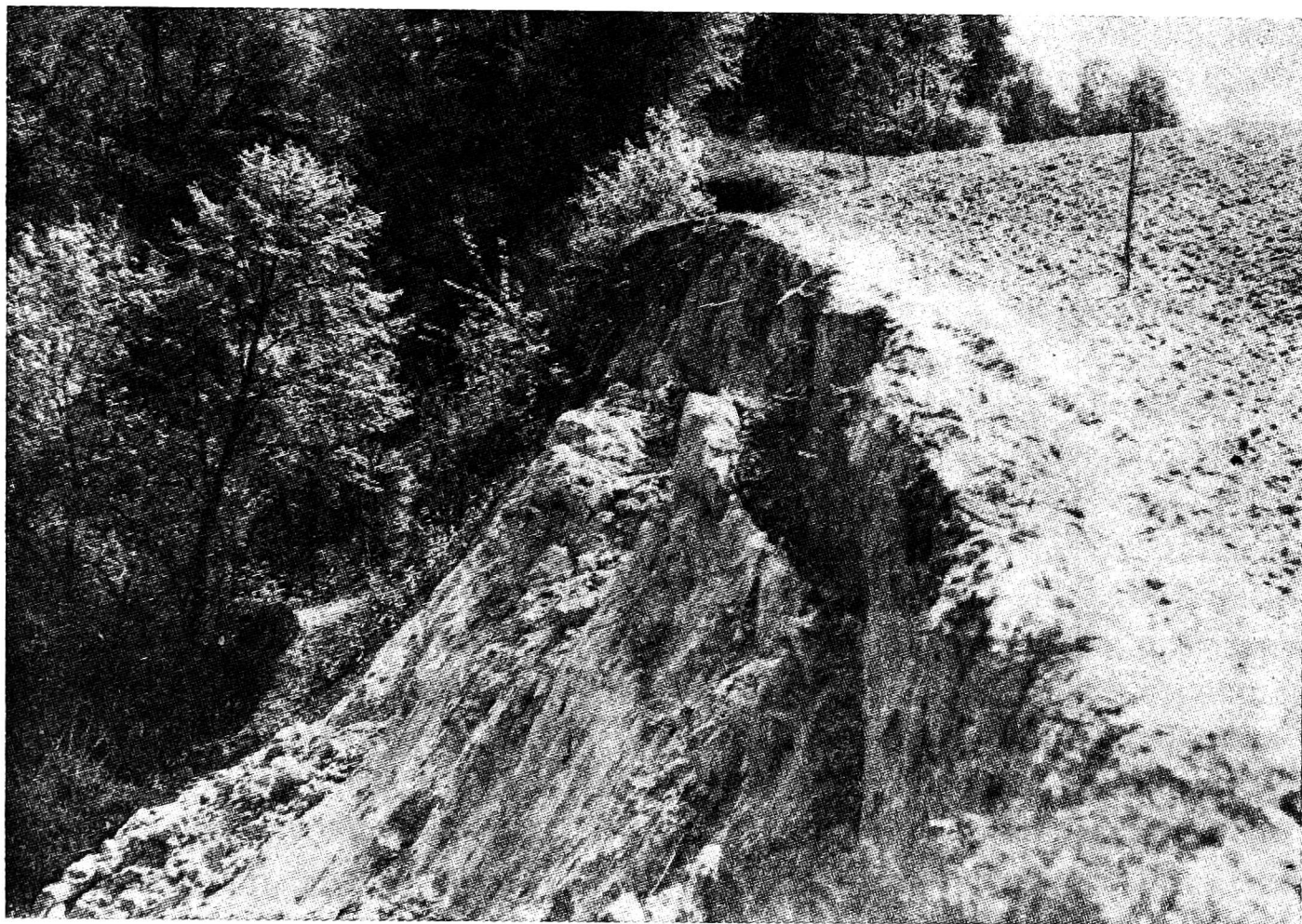
Rys. 3. Obrywy i osunięcia się ściany wąwozu „Kwaskowa Góra” 1967 r. (fot. S. Ziemiński)
