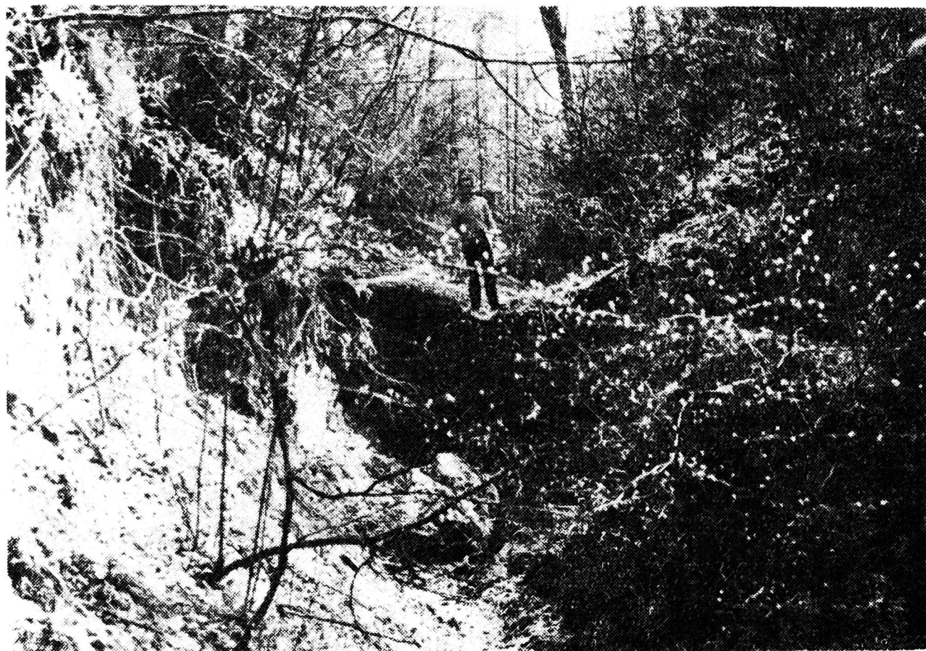
Rys. 5. Próg erozyjny powyżej hm 1+40. Widoczna roślinność na zboczach i w dnie wąwozu. Fot. S. Ziemnicki
