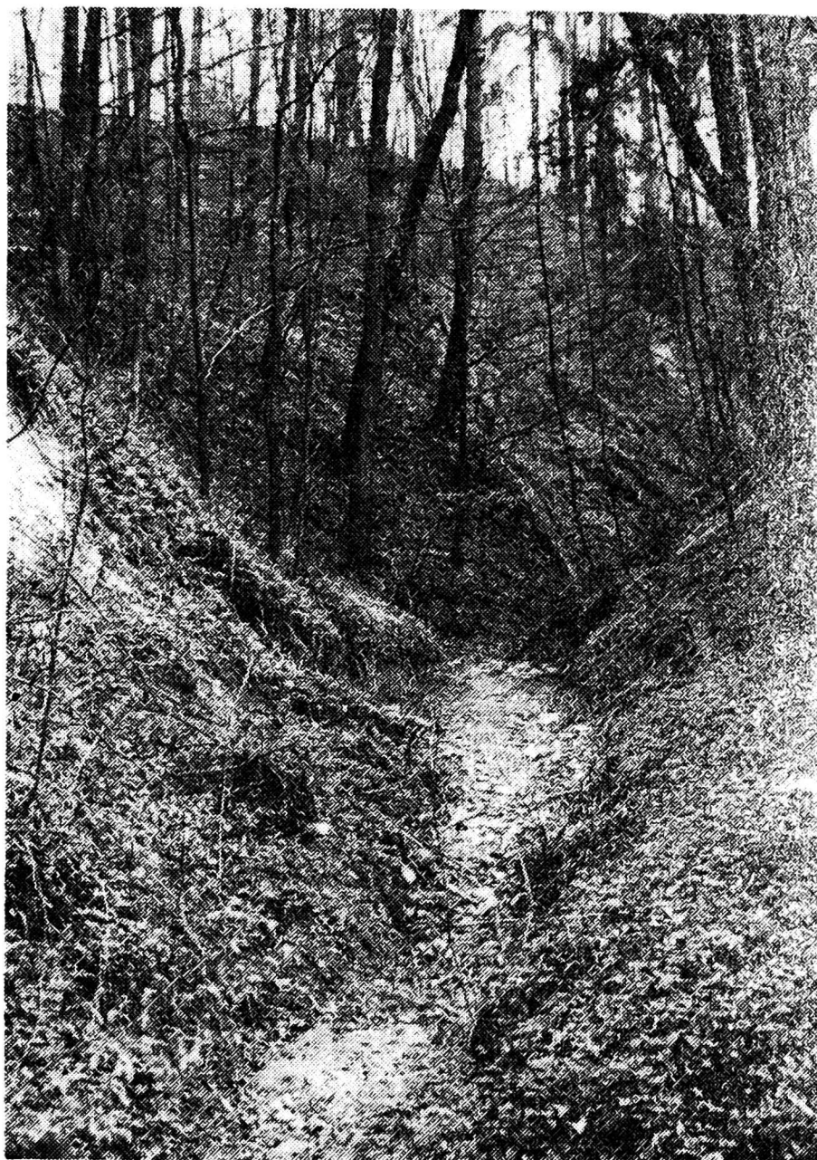
Rys. 4. Erozja dna dolnego odcinka wąwozu. Widoczne okruchy opoki kredowej. Fot. Zb. Bobowski
