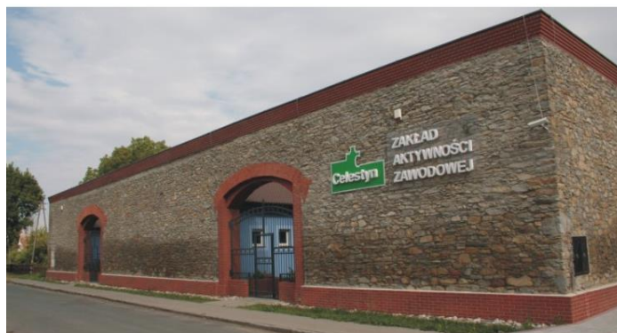
Fot. 5. Zakład Aktywności Zawodowej w Mikoszowie zlokalizowany w zaadaptowanym zabytkowym budynku gospodarczym
