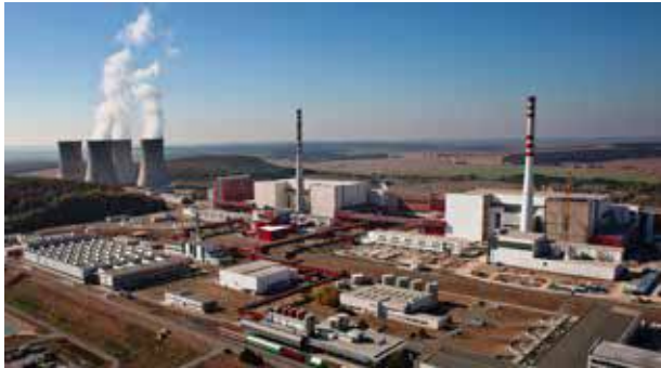
Fot. 2. Widok na EJ Mochovce (Słowacja)
