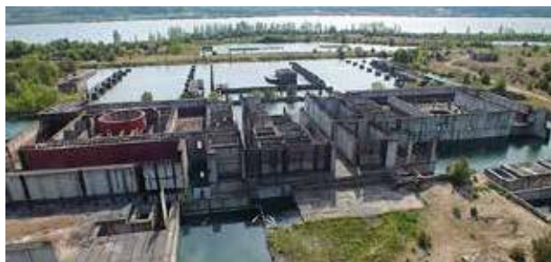
Fot. 5. Widok na obiekty porzuconej budowy I etapu EJ „Żarnowiec” (fot. NCBJ, dzięki uprzejmości Pomorskiej Specjalnej Strefy Ekonomicznej) Photo 5. A view of the facilities of the abandoned Żarnowiec NPP 1 st construction stage. Photo by NCBJ, by courtesy of Pomorska Specjalna Strefa Ekonomiczna
