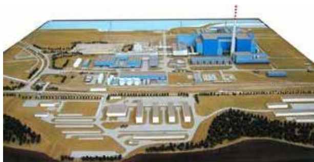
Fot. 4. Makieta I etapu EJ „Żarnowiec” Photo 4. Mock-up of the Żarnowiec NPP
