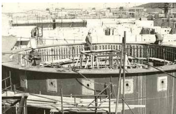
Fot. 11. Prace zabezpieczające w rejonie szybu reaktora 1 bloku. Czerwiec 1990 r. (fot. S. Wiesiołowski; EJŻ)
