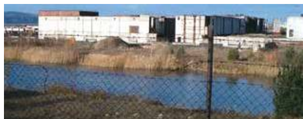
Fot. 6. Widok od strony południowej na porzucone obiekty I etapu EJ Żarnowiec (fot. Władysław Kielbasa) Photo 6. A southern view of the facilities of the abandoned Żarnowiec NPP 1 st construction stage. Photo by W. Kielbasa
