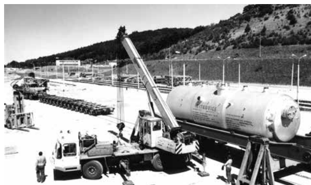
Fot. 12. Dostawa i rozładunek wytwornic pary na terenie budowy. Czerwiec 1990. (fot. S. Wiesiołowski; EJŻ)
