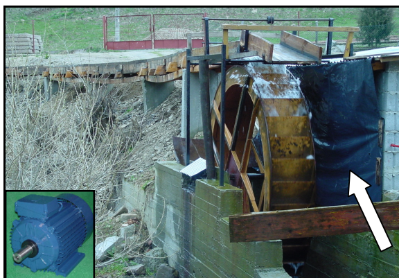
Rys. 17. Mała przydomowa elektrownia wodna w wykonaniu amatorskim o mocy 1.5 kW
