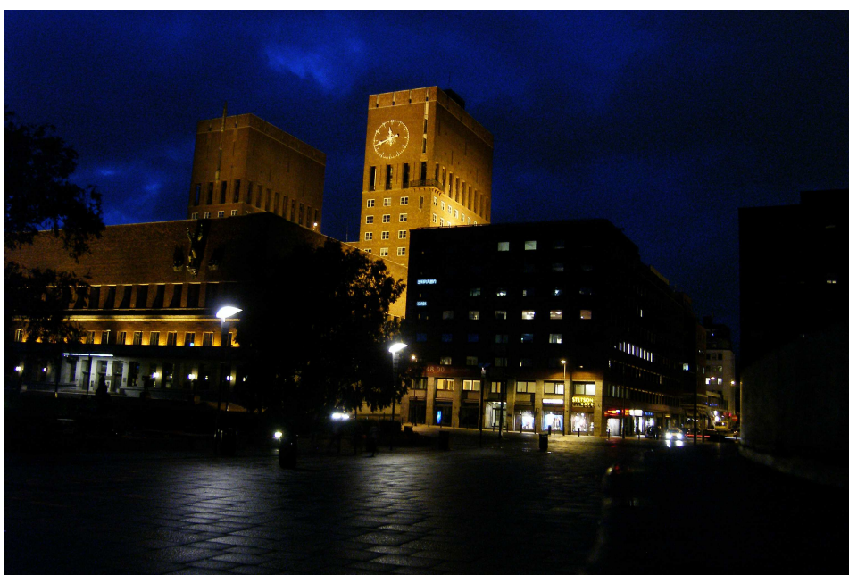
Rys. 5. Oslo, budynek Ratusza. Podkreślenie przestrzennej formy obiektu poprzez oświetlenie wyłącznie jego fragmentu
