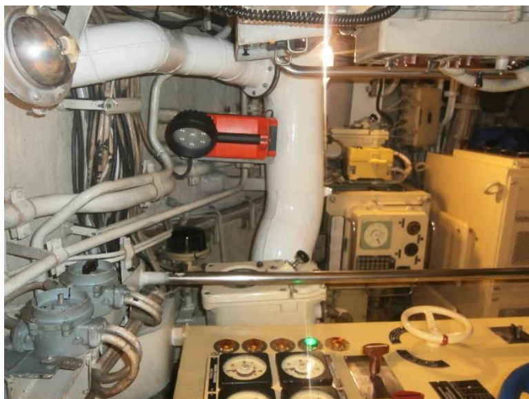
Rys. 5. Oświetlenie Litebox E-Flood zamontowane na ORP ORZEŁ Źródło: Opracowanie własne.
