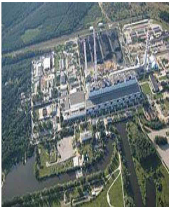
Rys. 1. Elektrownia Dolna Odra.
