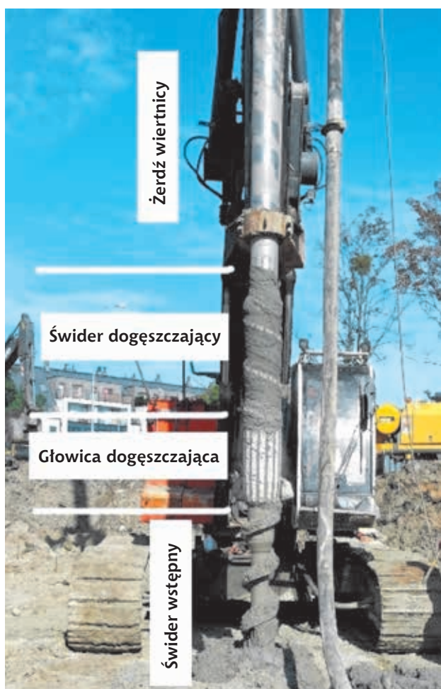
Ryc. 1. Świder do wykonywania kolumn CMC
