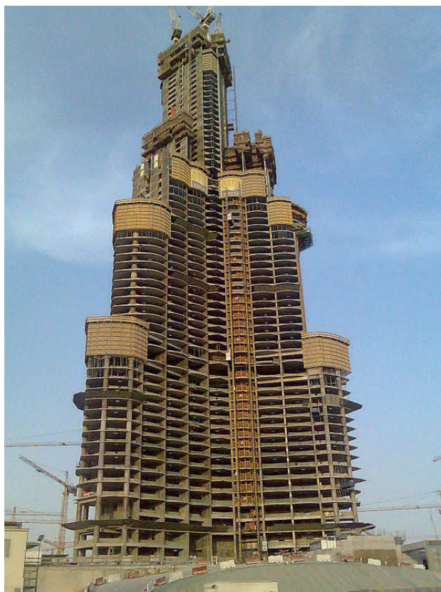
Fig. 6 The picture of the highest skyscraper in the world being under construction, where quality ashes were used. Rys. 6 Zdjęcie najwyższego drapacza chmur świata w czasie budowy gdzie stosowano popioły kwalifikowane
