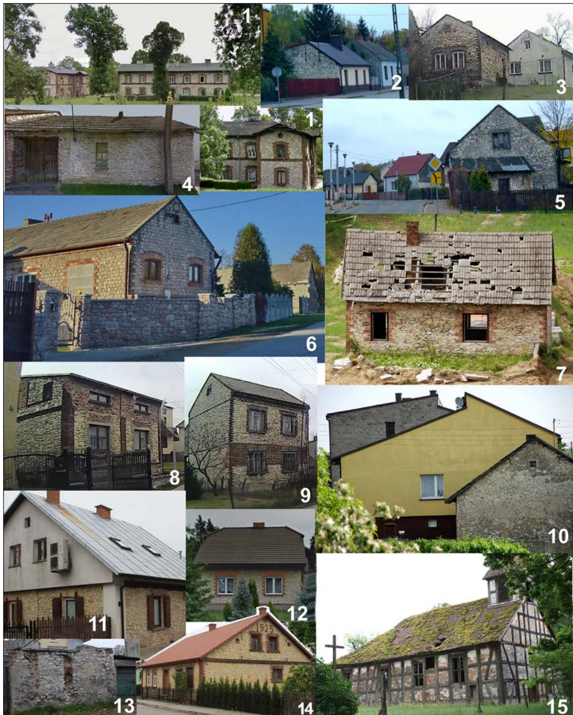
Ryc. 6. Budownictwo mieszkalne, przykłady; 1. Wrzosowa, osiedle fabryczne cementowni z początku XX w., 2. Janów, 3. Gołąsza, 4. Włodowice, 5. Janów, 6. Mirów, 7. Olsztyn, 8. Gołąsza Dolna, 9. Gołąsza Bliska, 10. Wojsławice, 11. Zmodernizowany budynek mieszkalny w Szczepieszynie, 12. Rudniki, 13. Żarki, 14. Szczepieszyn, 15. Niszczący zbór protestancki w Drawinach, [położenie miejscowości; 1-2-5-6-7-9-12. powiat częstochowski, 3-8-9. powiat będziński, 4. powiat zawierciański, 10-13. powiat myszkowski, 11-14. powiat zamojski 15. powiat strzelecko-drezdenecki, ryc.10]. Źródło: opracowanie własne
