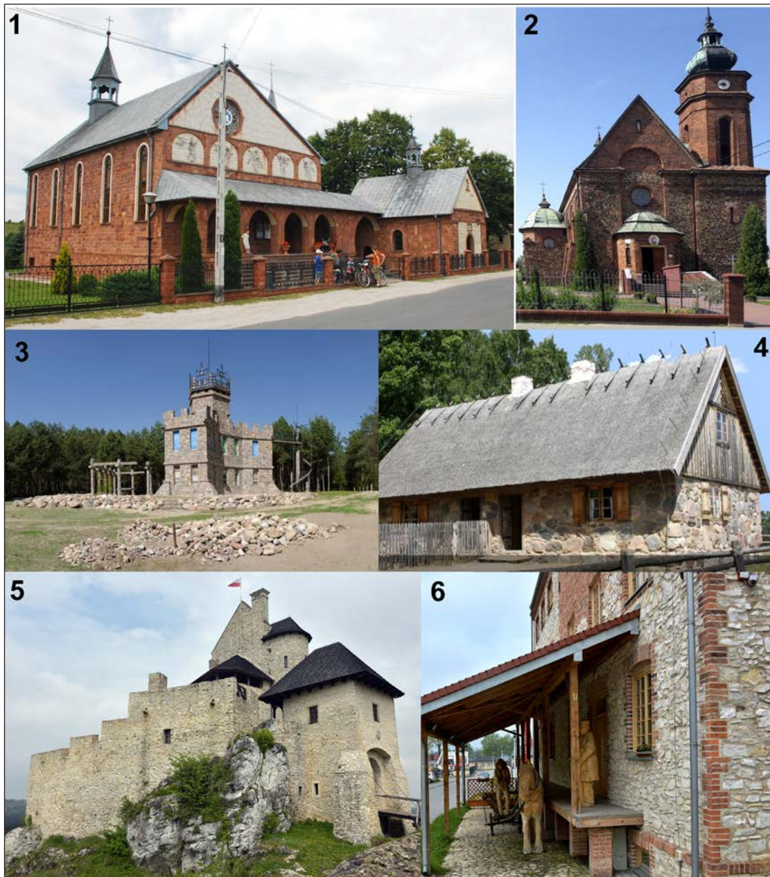
Ryc. 9. Budownictwo z wykorzystaniem kamieni – współczesne, przykłady; 1. Polichno, kościół z piaskowca, 2. Starcza, kościół z głazów lokalnych moren, 3. Anusin – Siemiatycze, zamek budowany współcześnie z głazów narzutowych, 4. Olsztynek, dom odtworzony w Muzeum Budownictwa Ludowego, 5. Bobolice, odrestaurowany zamek, 6. Żarki, muzeum Dawnych Rzemiosł w Starym Młynie. [położenie miejscowości; 1. powiat kielecki, 2. powiat częstochowski, 3. powiat siemiatycki, 4. powiat olsztyński, 5-6. powiat myszkowski, ryc.10]. Źródło: opracowanie własne
