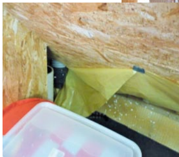
Kominek odpowietrzający z rurą łącznikową ø100 mm
