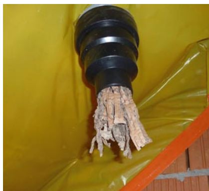
Rys. 5. Kominek odpowietrzający zatkany ścinkami papieru
