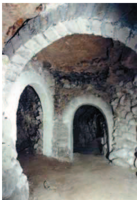
Ryc. 7. „Grota Puławska” zabezpieczenie chodników i schemat wzmocnienia największej komory Fig. 7. Puławska Cavern – protection of headings and diagram of reinforcement of the largest cavern
