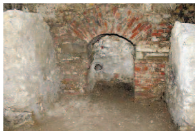
Kramy Bogate – widok na wzmocnione ceglany łękami fundamenty Sułkiewicz
