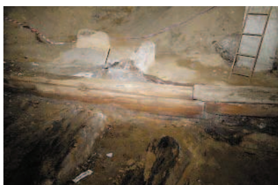
XIII-wieczny wodociąg wykonany z drążonych belek drewnianych
