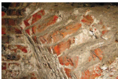
Fragment zachowanego ceglanego sklepienia piwnic budynku Wielkiej Wagi
