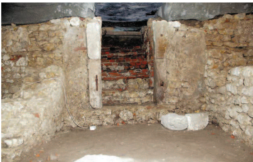
Pierwotny otwór wejściowy do piwnic Kramów Bogatych
