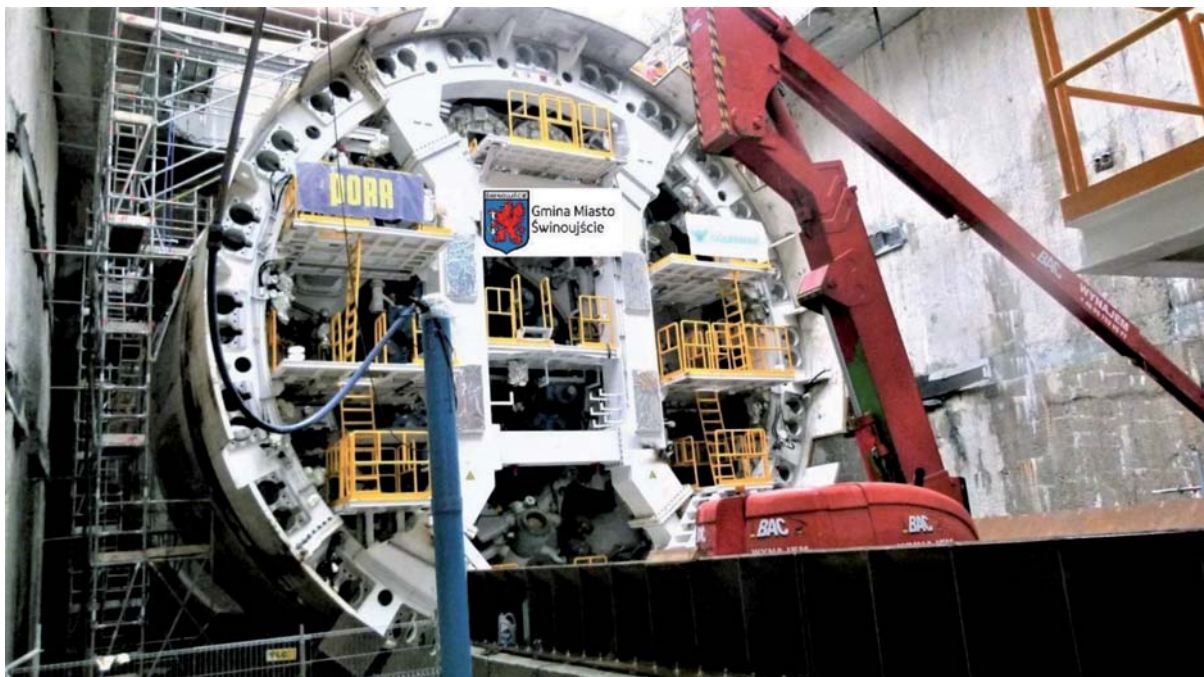
Fot. 1. Maszyna TBM „Wyspiarka”
