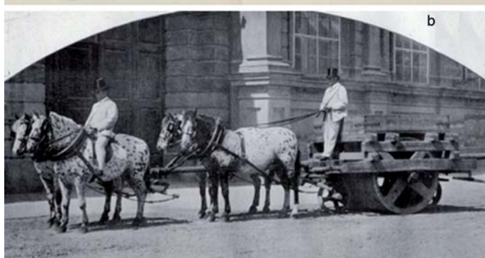
Rys. 3. Walec żelwny obciążony skrzynią z kamieniami: a – Schattenmann 1842, b – Schattenmann (fot. z 2 poł. XIX w.)
