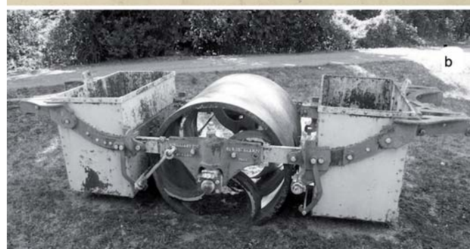
Rys. 4. Przykłady walców wytwarzanych w odlewni Bouilliant: a – z platformą transportową 1848, b – ze skrzyniami obciążającymi 1858 (fot. z 2 poł. XIX w.)
