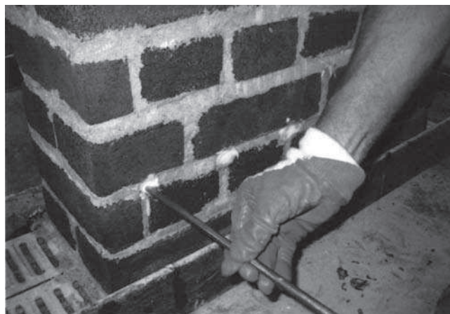
Rys. 2. Aplikacja kremu iniekcyjnego w metodzie WTA 8 [4]
