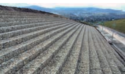
Dostawa i montaż gabionów w m. Przybędza
