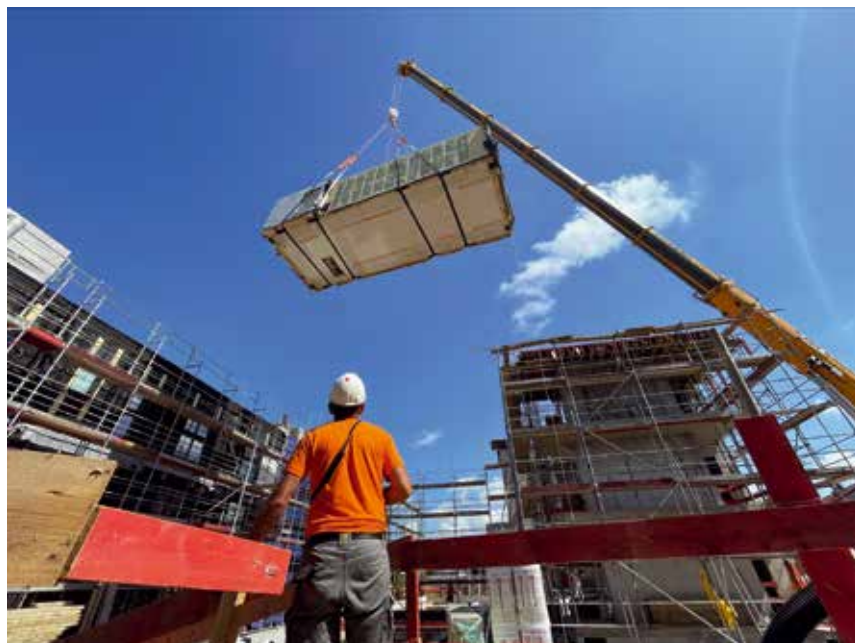
Rys. 1. Moduł przestrzenne firmy Unihouse montowany na placu budowy; źródło: materiały promocyjne Unihouse
