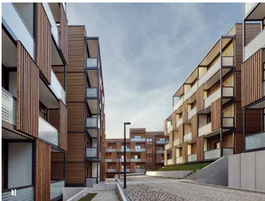
Rys. 2. Modułowe budynki mieszkalne realizowane przez Unihouse, a. Signaturhagen w Kongsbergu, Norwegia, b. SWSG w Stuttgardzie, Niemcy; źródło: materiały promocyjne Unihouse
