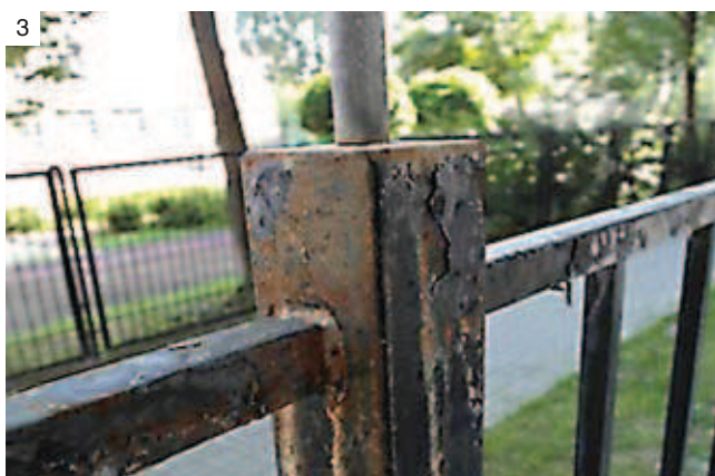
Fot. 1. Korozja galwaniczna wkrętów wykonanych z ocynkowanej stali w kontakcie ze stalą nierdzewną
