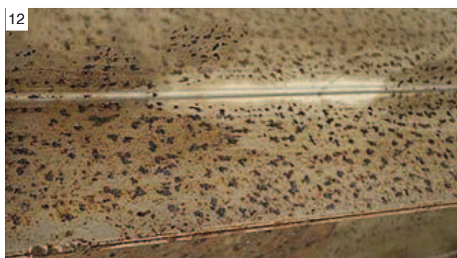
Fot. 7–12. Przebarwienia, rdzawe plamy i wżery korozyjne na stalowych elementach pływalni powstałe na skutek zastosowania nieodpowiedniego gatunku stali do warunków eksploatacji i/lub niewystarczającej konserwacji
