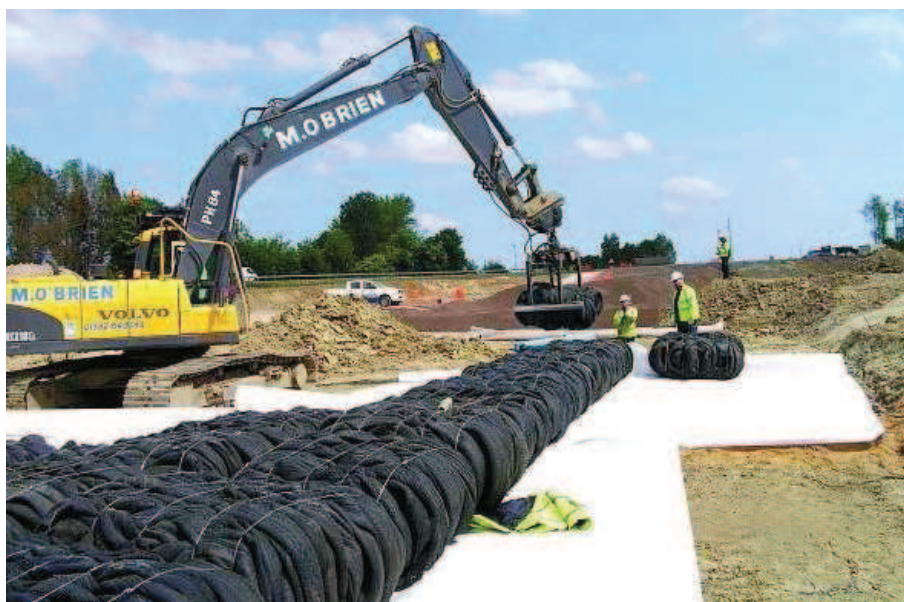
Rys. 7. Instalacja pakietów gumowych [24]
