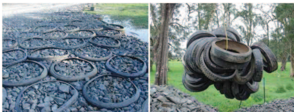
Rys. 2. Z lewej konstrukcja nawierzchni z opon, z prawej transport całych opon [12]
