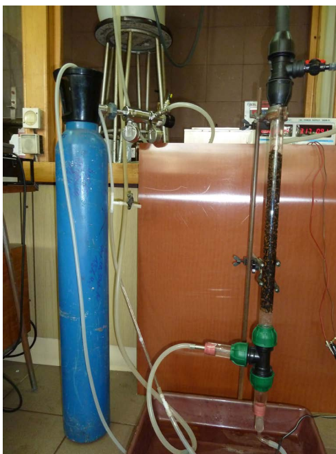
Rys. 2. Widok ogólny laboratoryjnego reaktora do usuwania siarkowodoru
