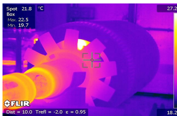
Rys. 20. termogram wirnika silnika indukcyjnego o mocy 6,3 MW
