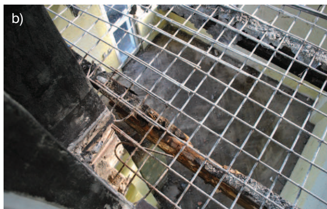
Rys. 2. Strop nad II piętrzem wielorodzinnego budynku mieszkalnego stanowiącego przedmiot artykułu czasie prac remontowych: a) uszkodzenia ścian w narożniku, widoczne gniazda oparcia belek na murze oraz styropian pod żelbetową płytą stropową, b) uszkodzona drewniana belka stropowa przy kominie, widoczny szczegół zbrojenia płyty żelbetowej
