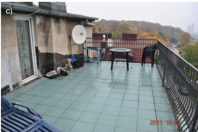
Rys. 1. Wielorodzinny budynek mieszkalny stanowiący przedmiot artykułu: a) elewacja frontowa, b) widok połaci dachowej na sąsiednim budynku z nieprzebudowanym stropodachem, c) widok tarasu powstałego w wyniku samowolnie prowadzonych prac budowlanych, d) uszkodzenia w miejscu oparcia żelbetowej płyty tarasu na murach zewnętrznych, e) uszkodzenia gzymsu, f) sposób montażu balustrady ochronnej
