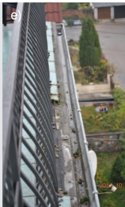
Rys. 1. Wielorodzinny budynek mieszkalny stanowiący przedmiot artykułu: a) elewacja frontowa, b) widok połaci dachowej na sąsiednim budynku z nieprzebudowanym stropodachem, c) widok tarasu powstałego w wyniku samowolnie prowadzonych prac budowlanych, d) uszkodzenia w miejscu oparcia żelbetowej płyty tarasu na murach zewnętrznych, e) uszkodzenia gzymsu, f) sposób montażu balustrady ochronnej
