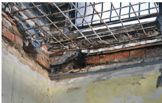
Rys. 2. Strop nad II piętrzem wielorodzinnego budynku mieszkalnego stanowiącego przedmiot artykułu czasie prac remontowych: a) uszkodzenia ścian w narożniku, widoczne gniazda oparcia belek na murze oraz styropian pod żelbetową płytą stropową, b) uszkodzona drewniana belka stropowa przy kominie, widoczny szczegół zbrojenia płyty żelbetowej
