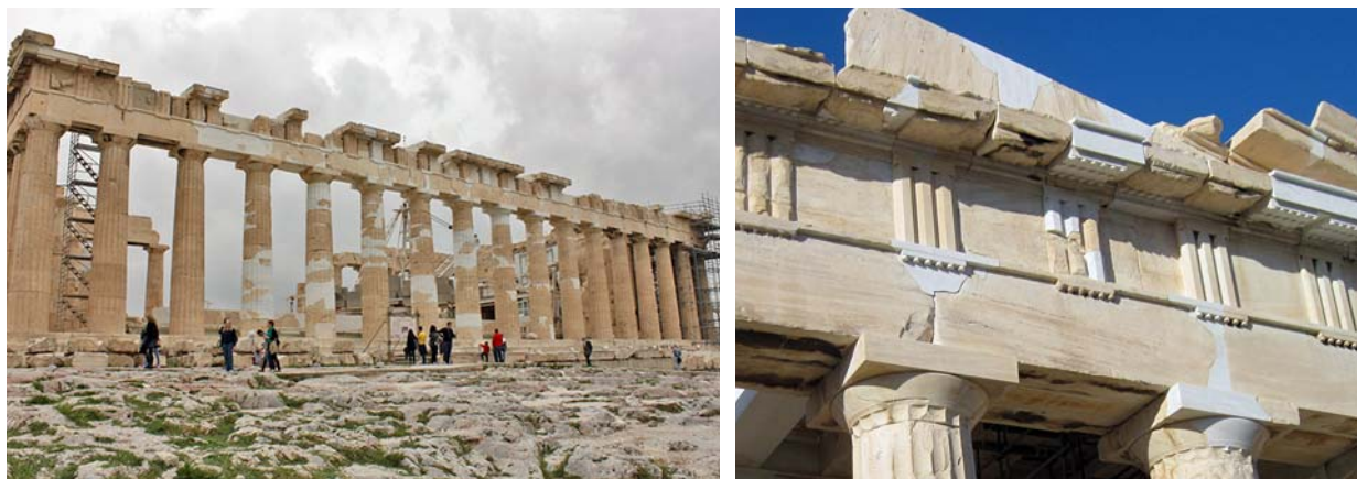
Ryc. 4. Stopniowa rekonstrukcja Partenonu na Akropolu w Atenach: kompilacja anastylozy wykorzystującej oryginalne elementy i nowych uzupełnień (po lewej) oraz fragment belkowania szczytu świątyni z wyraźnie odróżniającymi się nowymi uzupełnieniami (po prawej)
