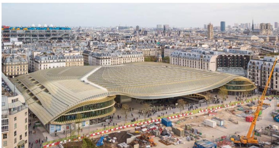
Fot. 1. Wielofunkcyjne przykrycie Canopee, Paryż (fot. Berger-Anziutti, http://patrickberger.fr/reamenagement-des-halles/ )
