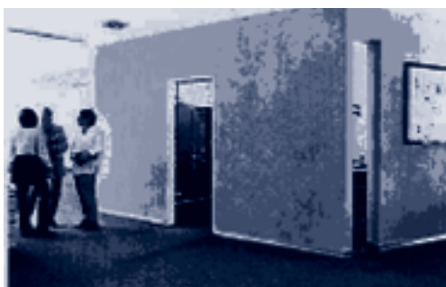
Rys. 4. Widok pomieszczenia biurowego – kabina dźwiękoizolacyjna stosowana jako pomieszczenie dla obsługi głośniejszych urządzeń lub pomieszczenie ciche, np. do prowadzenia poufnych rozmów [3]
