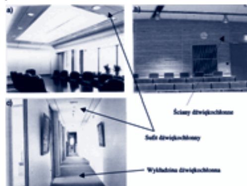
Rys. 8. Przykłady pomieszczeń biurowych, w których zastosowano materiały i ustroje dźwiękochłonne: a) sala konferencyjna, b) sala wykładowa, c) korytarz [3]
