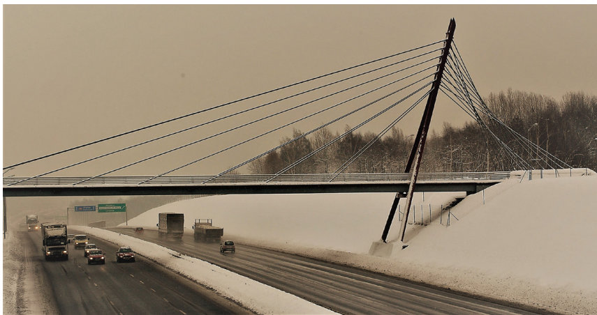
Fot. 5. Kładka nad autostradą A4, Ruda Śląska (fot. aut.)
