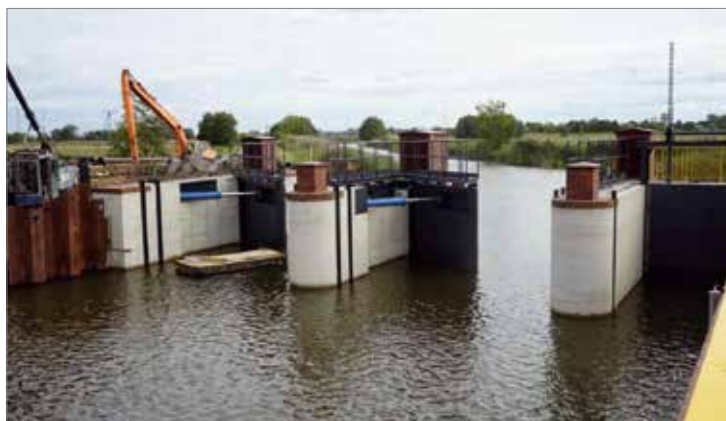
Fot. 1. Wrota przeciwsztormowe na Tudze; źródło: [3]
