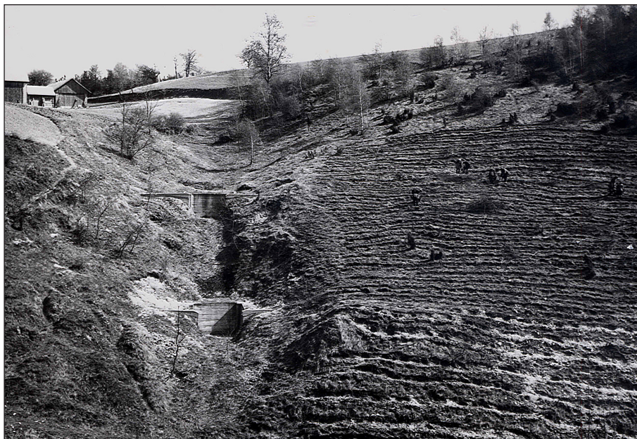
Fot. 5. Zalesianie stromych ścian wąwozu nr 2 na przygotowanych minitarasach naorywanych. Z lewej strony widoczne dwa stopnie skrzynkowe w odnodze bocznej wąwozu
