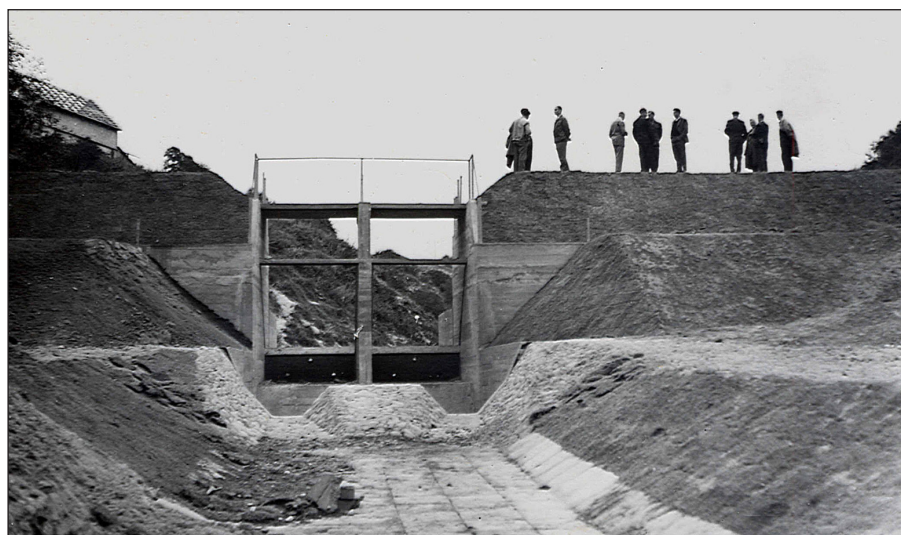
Fot. 4. Zapora przeciwrumowiskowa zamykająca wąwóz. Poniżej niej koryto odpływowe odprowadzające wodę przez stożek deluwialny Photo 4. The anti-rubble barrier closing the mouth of a gully. Below a channel leading the outflow through the deluvial cone can be seen
