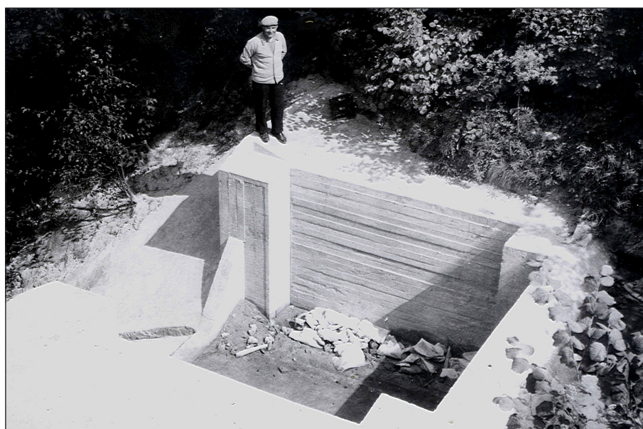
Fot. 2. Stopień skrzynkowy umacniający próg erozyjny (1964 rok) Photo 2. A box inlet spillway used to reinforce the erosion threshold (1964)
