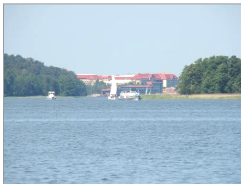
Ryc. 3. Bryła hotelu jako dyszharmonijne zamknięcie osi widokowej Jeziora Mikołajskiego (fot. W. Gadomska)
